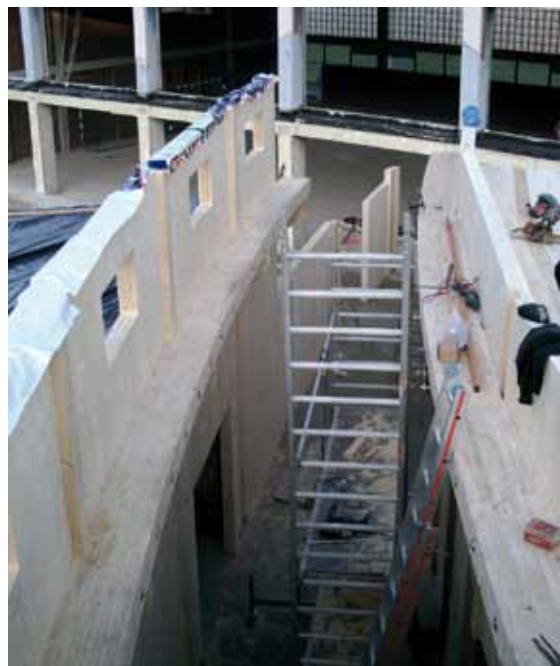
■ Mittelgang zur Turnhalle.
