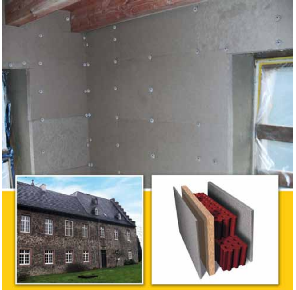
Referenz: Kloster Schweinheim, DEG Alles für das Dach eG
