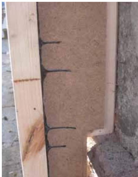
Detail Stegträger: Genaueste Anpassungen sind möglich.
