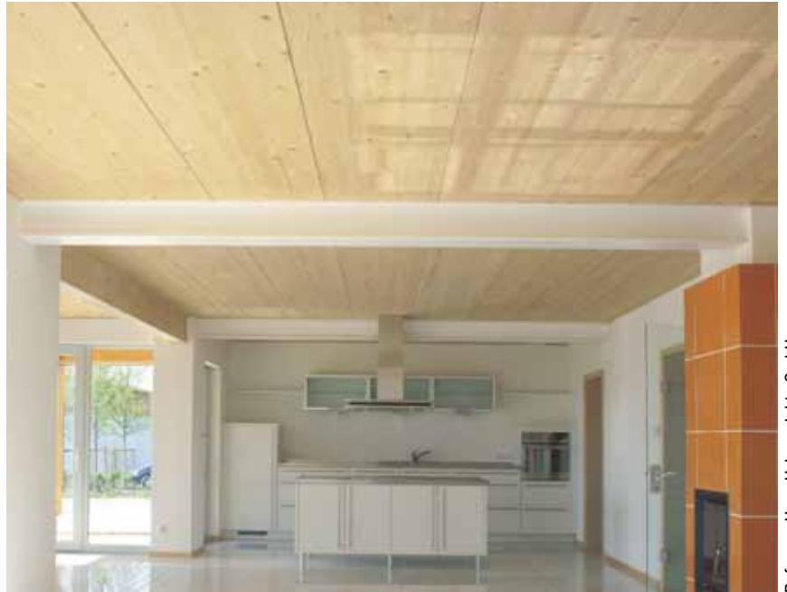
Untersicht einer Geschossdecke aus BSH-Elementen
