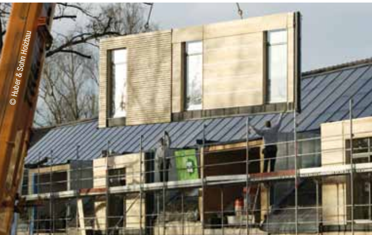
Montage komplett vorgefertigter Fassadenelemente.
