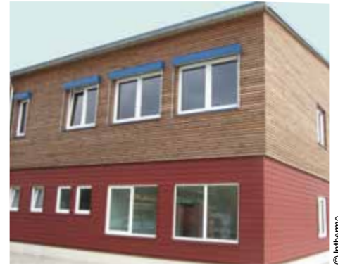
VHF mit Lärchenschalung, im EG deckend gestrichen, im OG transparent wasserabweisend behandelt.
